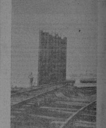
Una sección de 12 grandes piezas de acero, que tienen que ser hundidas a golpes de martillo de vapor, hasta el nivel del piso. La altura de las estacas puede calcularse por la del hombre que aparece al lado y que es de elevada estatura.
